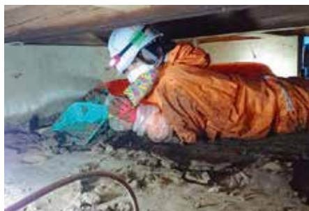
床下の泥だしの様子
