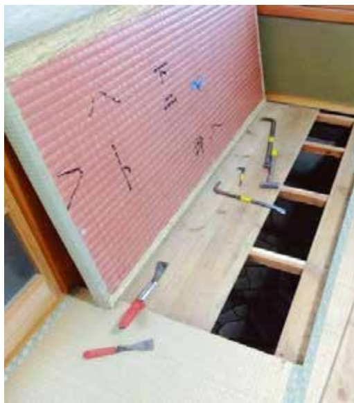
和室の床板をはがす（写真①）
